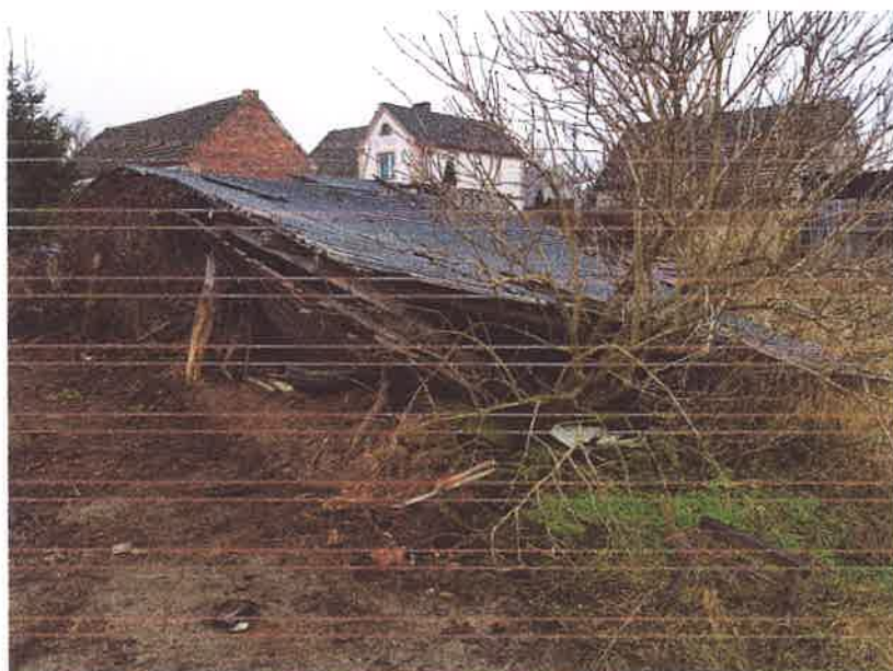
Fot. Nr 3 – Widoczne bok szopy oraz fragmenty desek z poszycia ścian oraz widok więźby dachowej z pokryciem.
