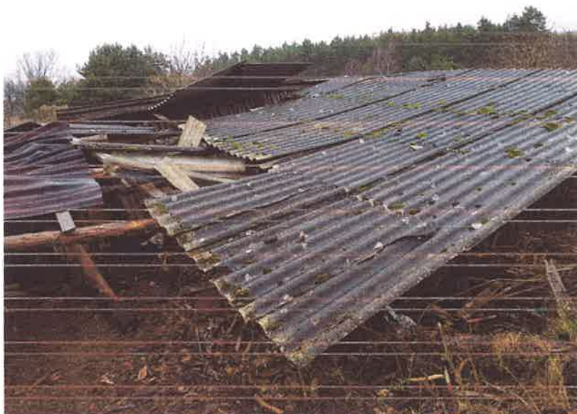
Fot.Nr 2 – Widoczne fragmenty konstrukcji dachowej oraz pokrycie z płyt azbestowych
