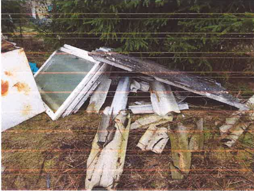
Fot. Nr Widoczne elementy stolarki oraz luźnego pokrycia dachowego z płyty azbestowej
