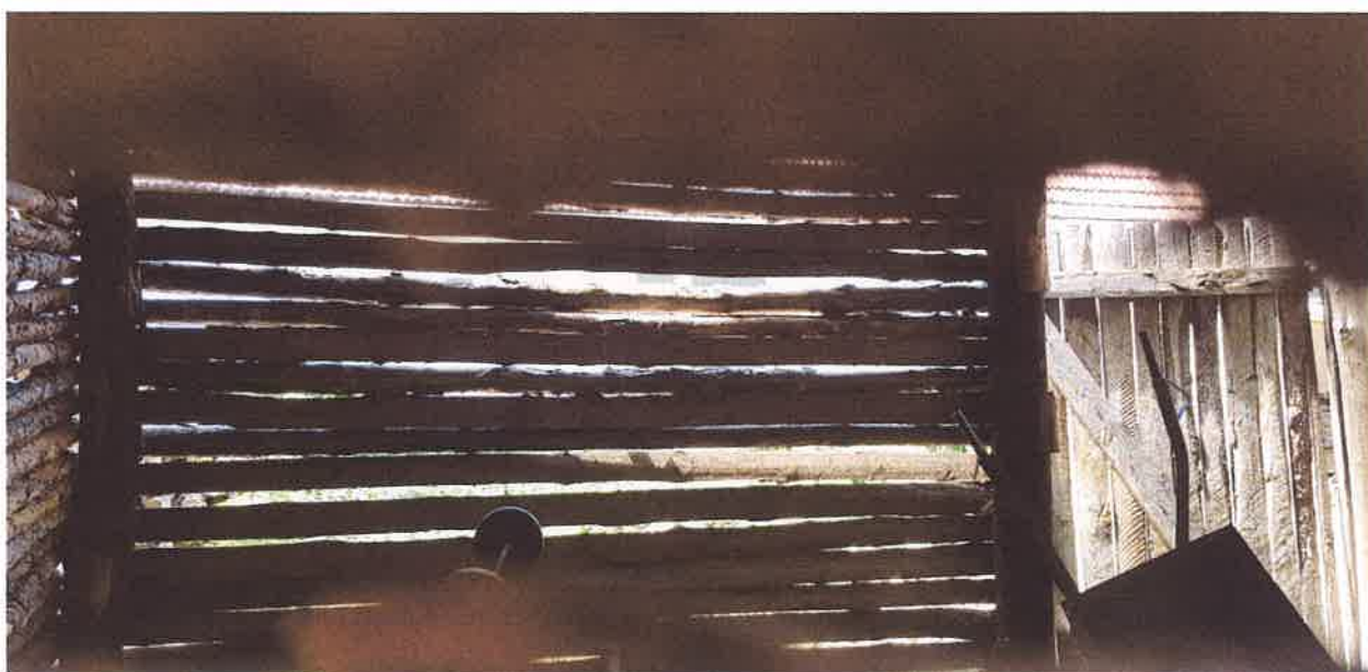
Ściany budynku z żerdzi drewnianych
